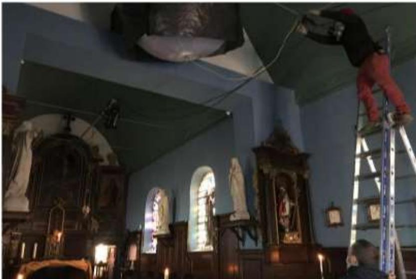
Les murs blancs de l'église ont été repeints en bleu-gris.
