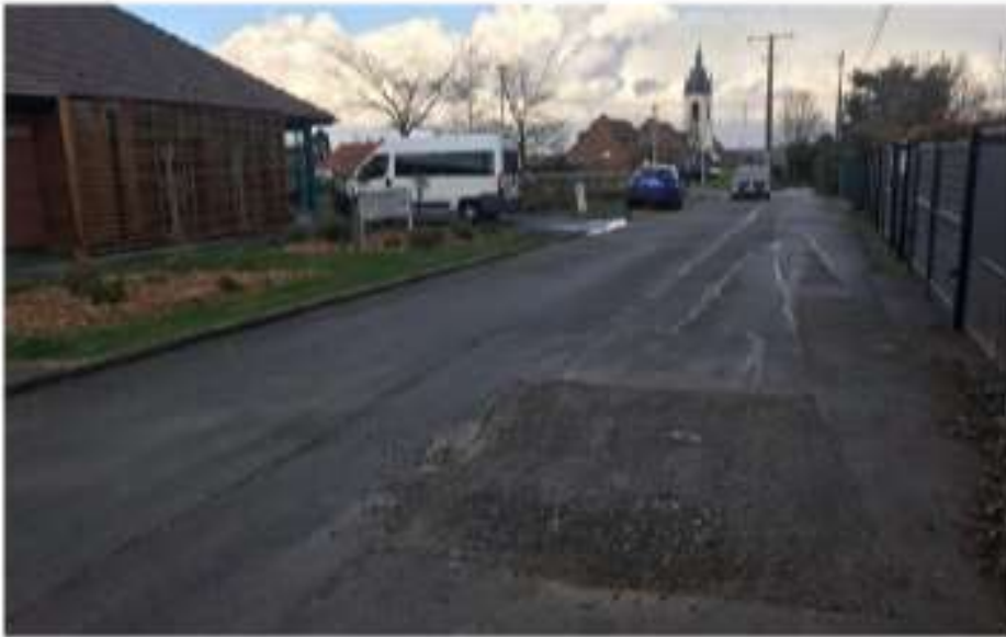
À Sebourg, le trou, que ne faisait que 80 cm de profondeur, a pu être comblé dès vendredi soir.
