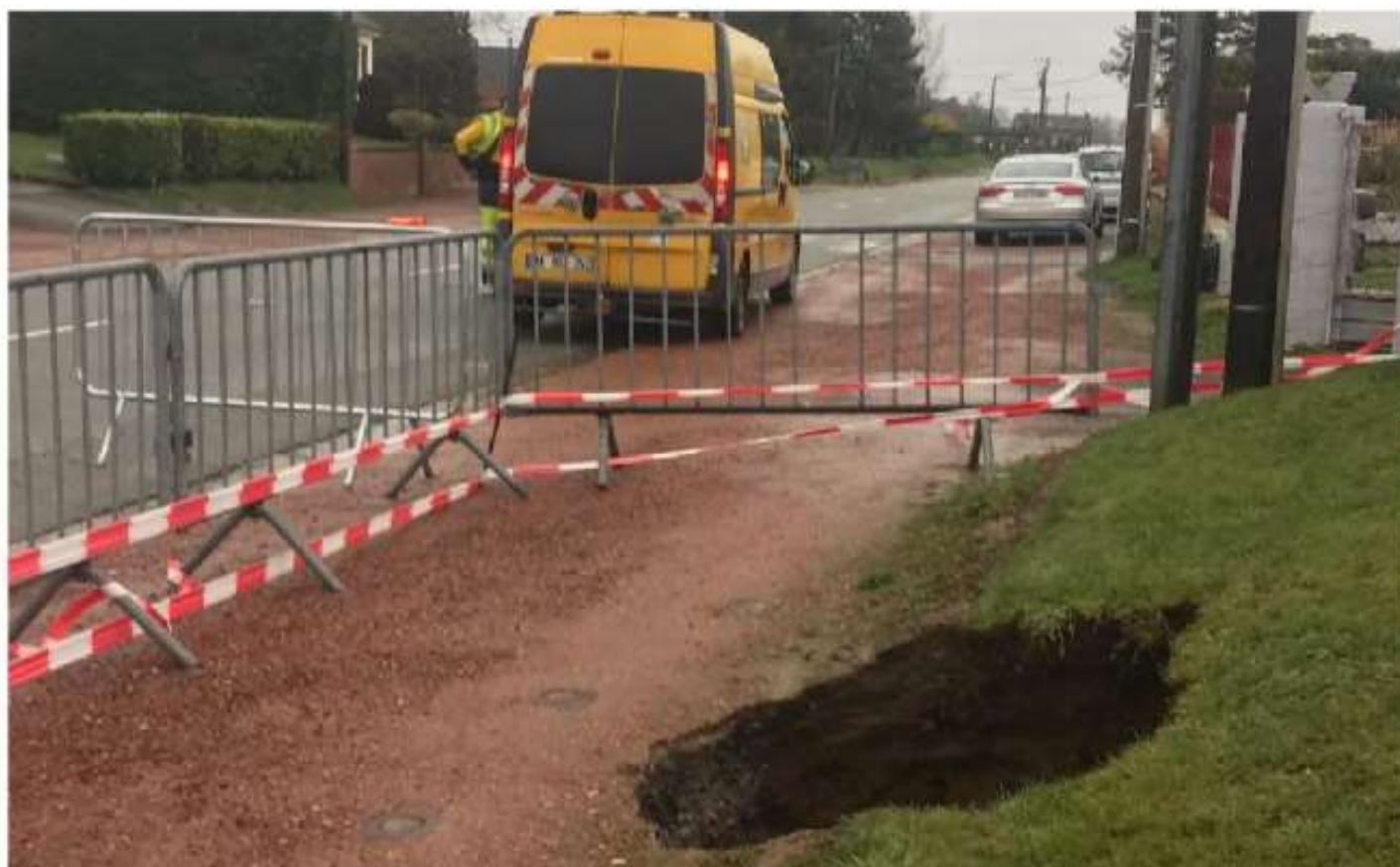
Le trou doit faire entre 10 et 25 mètres de profondeur. La circulation est coupée, entre Rombies et Quiévrechain.
