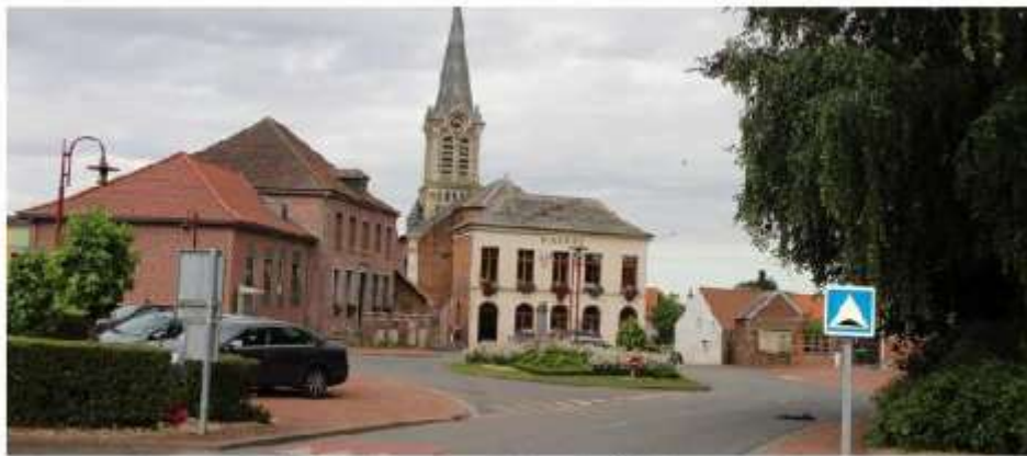
Cette année verra la fin de la restauration de l'église « qui sera accessible aux personnes à mobilité réduite ».
