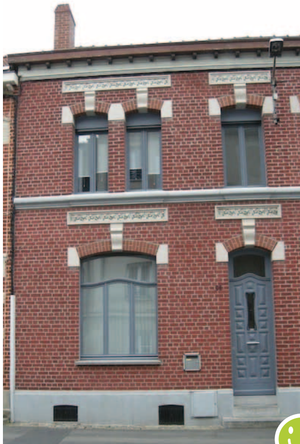
Restauration au moyen de joints gris, lecture de la maçonnerie respectée
