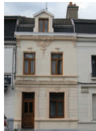
Façade avec un enduit ciment
