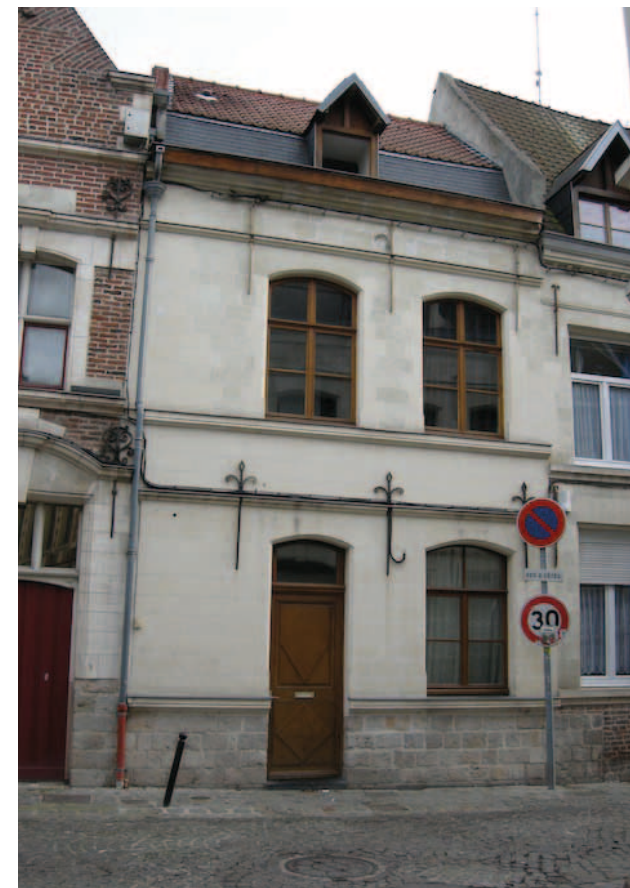
Restauration au moyen de pierre de nature proche, les différences de teinte ne sont pas trop marquées.
