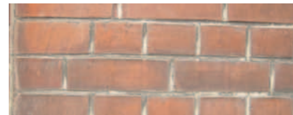
Jointes lissés au fer
