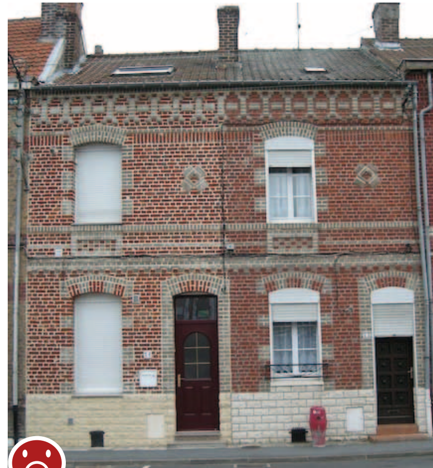
Restauration au moyen de joints trop clairs et non différenciés en fonction de la brique, perte de la lisibilité des décors et reliefs, mise en oeuvre de soubassements inadéquats sur les deux façades, et volets roulants en PVC blanc
