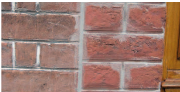
À droite restauration de joints hollandais au moyen de joints tirés au fer, application d'eau forte
