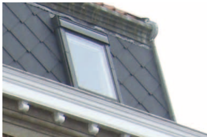
Ardoise fibre ciment à pose losangée
