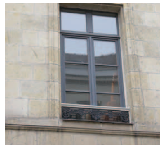
Garde corps 19 ème en fonte moulée et main courante en bois
