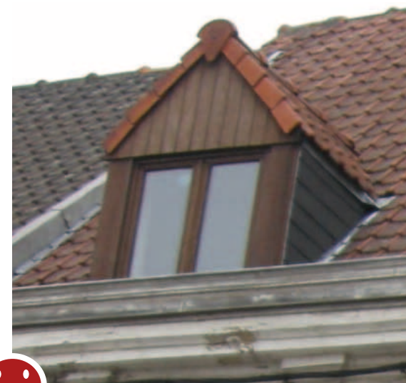
Mise en oeuvre de tuiles de rive
