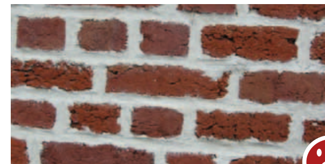
Nettoyage trop agressif des briques réduisant la taille des briques, joints trop blancs et trop épais
