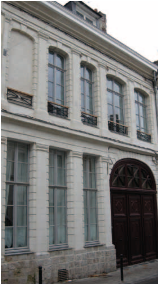
Façade en pierre restaurée
