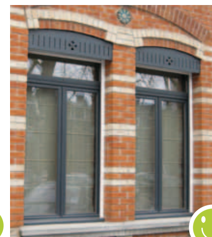
Exemple coffre de volet dissimulé derrière un lambrequin bois ajouré
