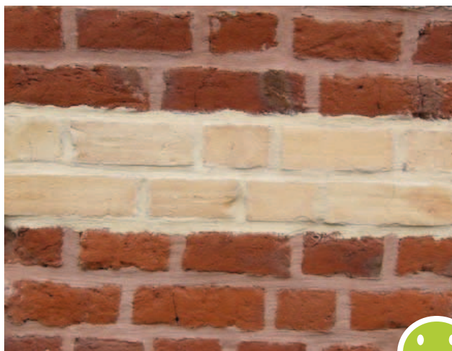
Jointes colorés à base de chaux
