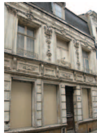
Exemple d'enduit à la bourre
