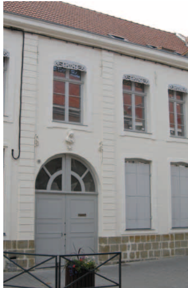
Façade en pierre badigeonnée
