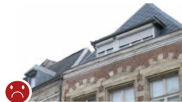
Venue en remplacement d'une lucarne à croupe, la lucarne « belle voisine » est inadaptée à la typologie.
