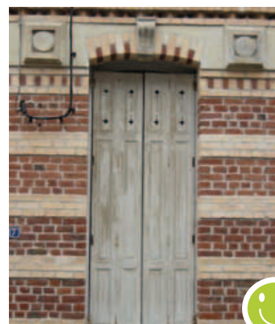
Exemple de volets pliants ajourés, les trous participent à la ventilation du logement
