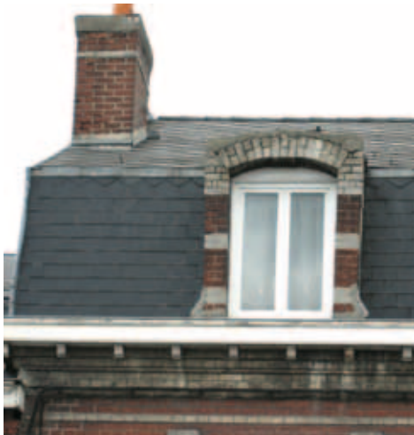
Lucarne à fronton maçonné
