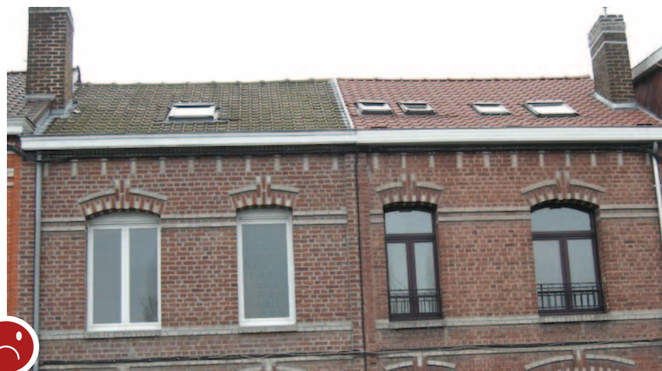
À gauche : compartimentage non respecté, imposte supprimée, les coffres de volets écrasent les proportions À droite : les menuiseries de façade conservent les compartimentages et les impostes sont alignées, mais les fenêtres de toits ne respectent pas les règles d'implantations
