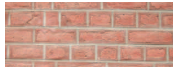
Jointes bicolores restaurés avec application de badigeon
