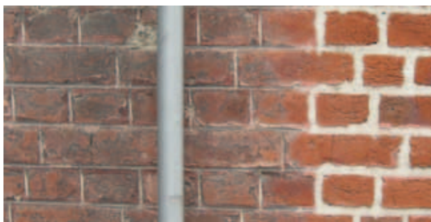
Exemple de mauvaise restauration de joint hollandais
