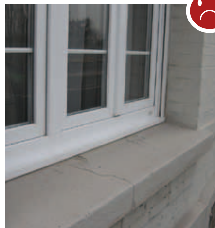
Menuiserie PVC sans relief, petit bois placé à l'intérieur du vitrage
