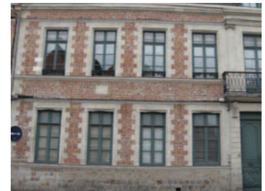
Façade brique et pierre
