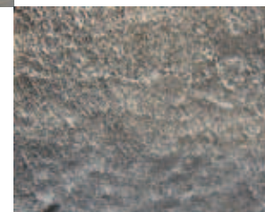
Exemple d'enduit à structure «nid d'abeille» ou enduit doigté.
