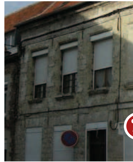
Caissons de volets roulants en saillie
