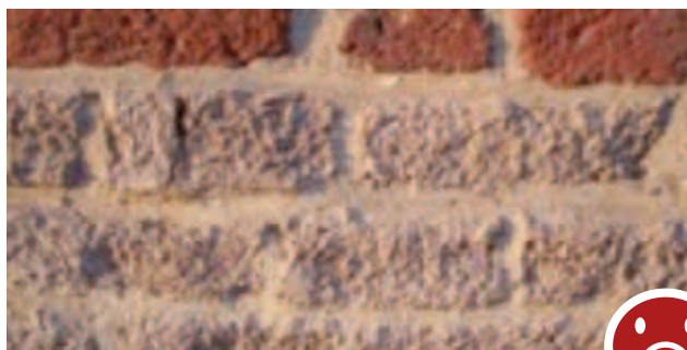
Sur cette photo, trop de pression et un abrasif trop gros ont abimé la brique
