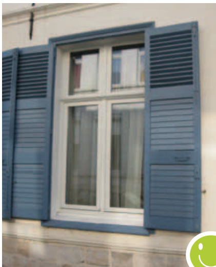
Exemples de volets battants à persiennes
