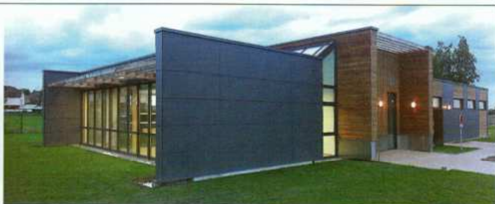
Saint-Amand-les-Eaux : Clinique vétérinaire de la Tour Equipe : ph. Faucret Architecte / Khéops Fluides
