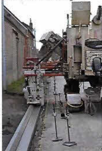
Borduration rue de l'Église.
