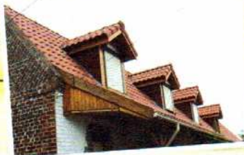
! répétition de lucarnes trop larges (à éviter)
