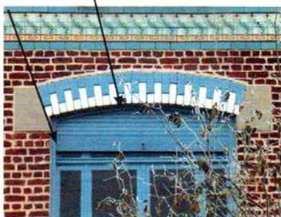
volet roulant avec caisson intégré à la maçonnerie
