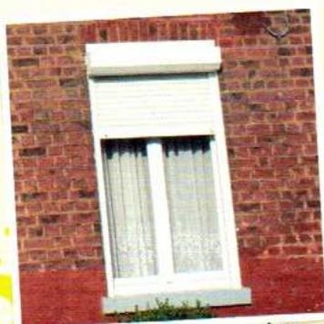
⚠ pose de volet roulant avec caisson extérieur (à éviter)
