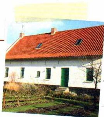
badigeon de chaux
