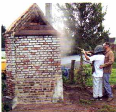
nettoyage à l'eau à haute pression
